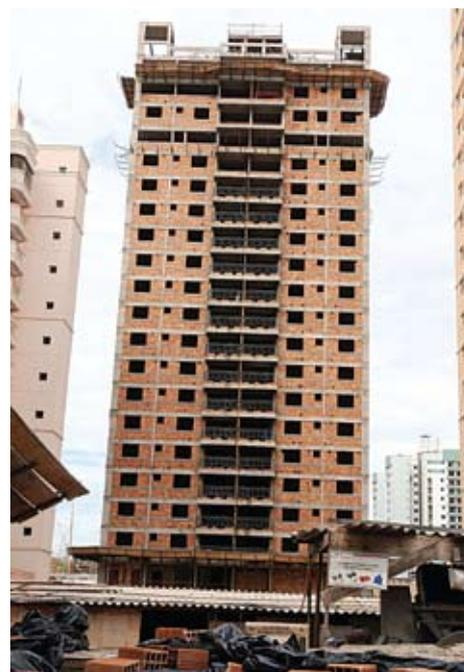
**BLOCO F** – Ainda em outubro serão concluídas as alvenarias dos pavimentos-tipo, a estrutura de concreto e as prumadas hidrosanitárias. Serão ainda atingidos 50% dos contrapisos e estão em andamento as instalações de gás, ramais de água e esgoto, prumadas elétricas, telefônicas e de incêndio.
