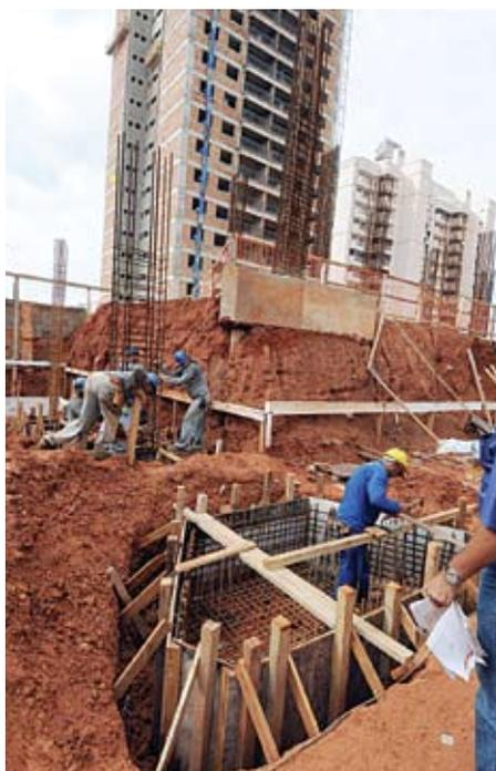
**BLOCO D** – Em outubro, atingimos 90% da concretagem dos blocos de fundação. Para novembro está prevista a execução da laje e das cortinas do subsolo. Previsto também o início da execução da laje do térreo.
